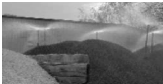
Aspersión ( humedecimiento ) de los agregados en su sitio de almacenamiento
