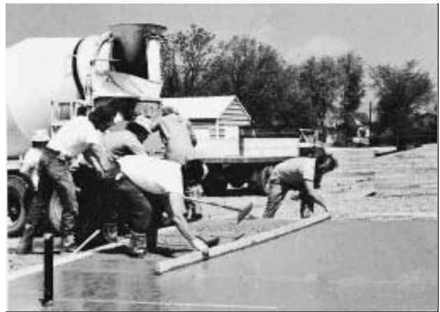
Acabado del concreto
