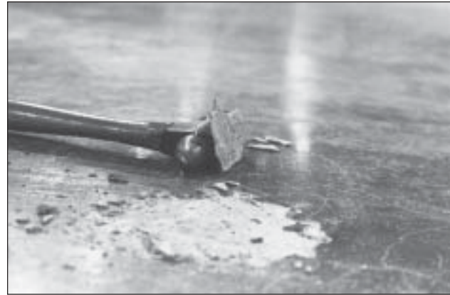
Concreto delaminado
