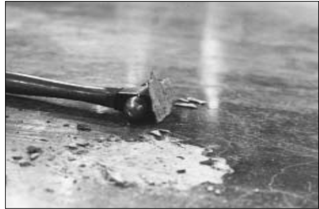
Concreto delaminado
