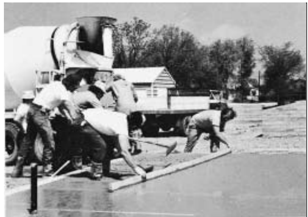
Acabado del concreto
